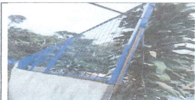
Foto 5: Sustrucción de enmallado
