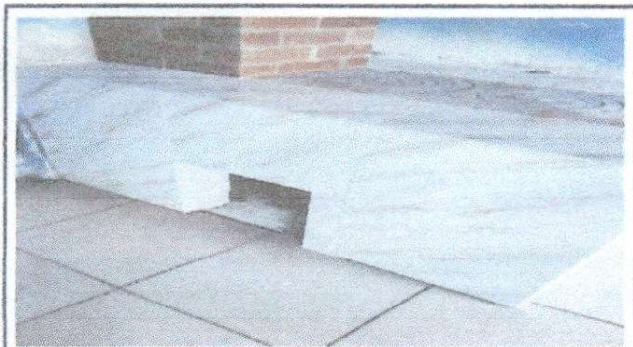
Foto 3: Reparación de estufa
