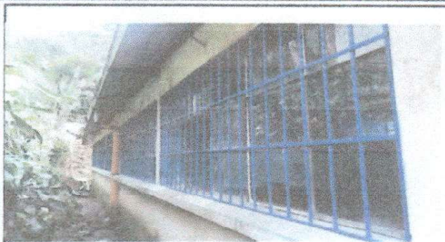
Foto 1: Sustrucción de balcones
