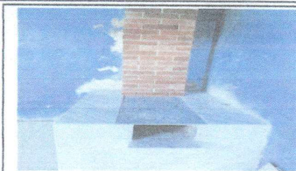
Foto 2: Reparación de Chimenea
