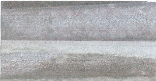
Foto 6: Repello de muro
